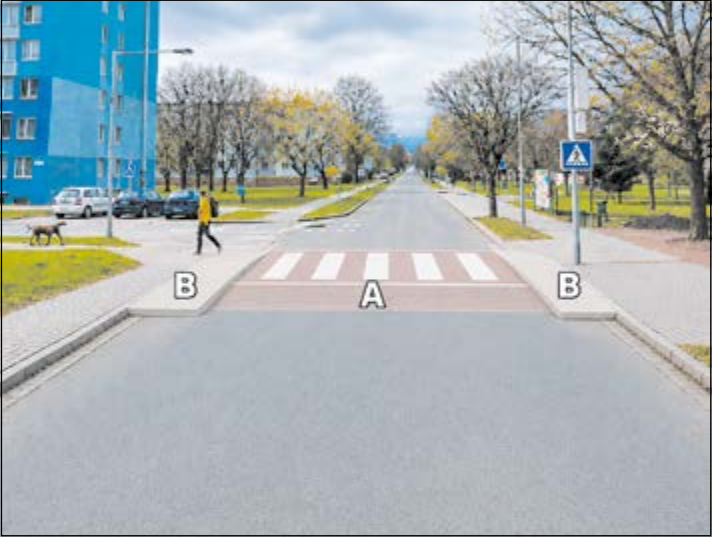
Přechod u ZŠ Slovan na Moravské ulici není příliš bezpečný, mnohá auta zde jezdí rychleji, než by měla. Proto navrhujeme úpravu. Zvýšený práh (8 cm, ve vizualizaci označený jako A) zpomalí vozidla, stejně jako nájezdové klíny (B). Přechod pak bude bezpečnější pro všechny účastníky provozu.
