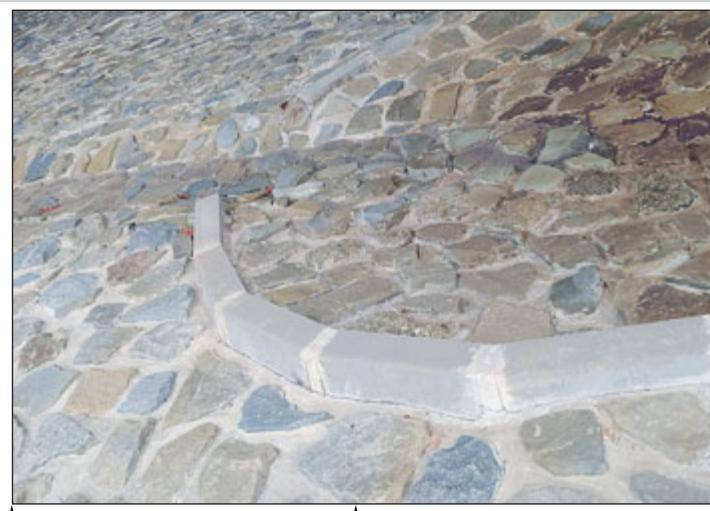
Takto vypadají profesionálně uložené kameny na břehu Moravy pod mostem. Jsou zabetonovány tak, aby se neuvolnily v případě velké vody. Když srovnáte, jak jsou uloženy kameny pod mostkem na březích Kotojedy, který je součástí nové cyklostezky Kotojedy – Vážany (foto na 1. straně), je rozdíl opravdu veliký.
