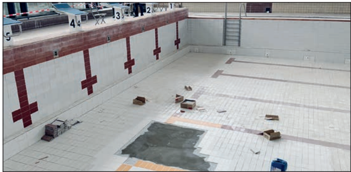
I hlavní bazén se opravuje v kroměřížském Plaveckém bazénu.
